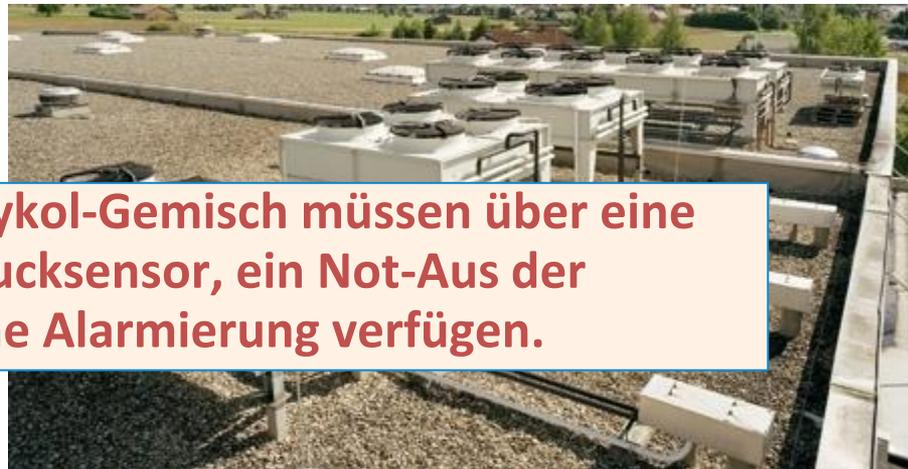
**Systeme mit  $> 1 \text{ m}^3$  Wasser-Glykol-Gemisch müssen über eine Lecküberwachung mit Drucksensor, ein Not-Aus der Kreislaufpumpe und eine Alarmierung verfügen.**
